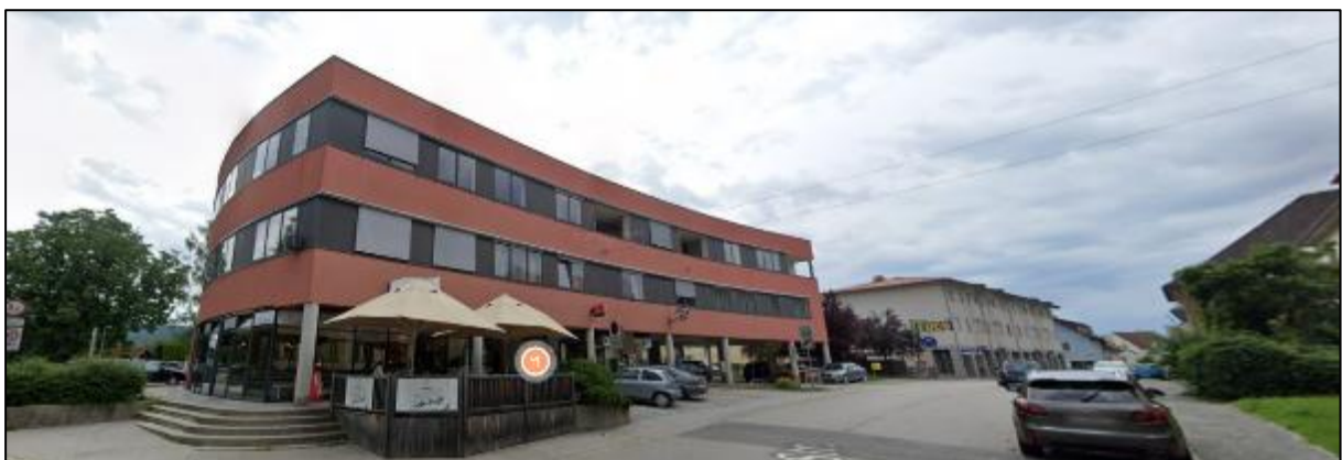
Abbildung 3: Bestandsgebäude in Griffner Str. (Quelle: Google)
