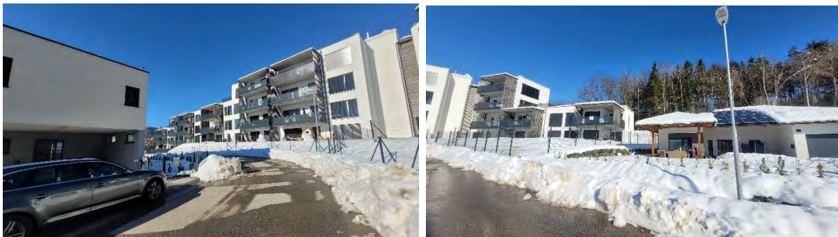
Abbildung 8: Mehrgeschoßwohnbau an der Nordgrenze des Planungsraumes
