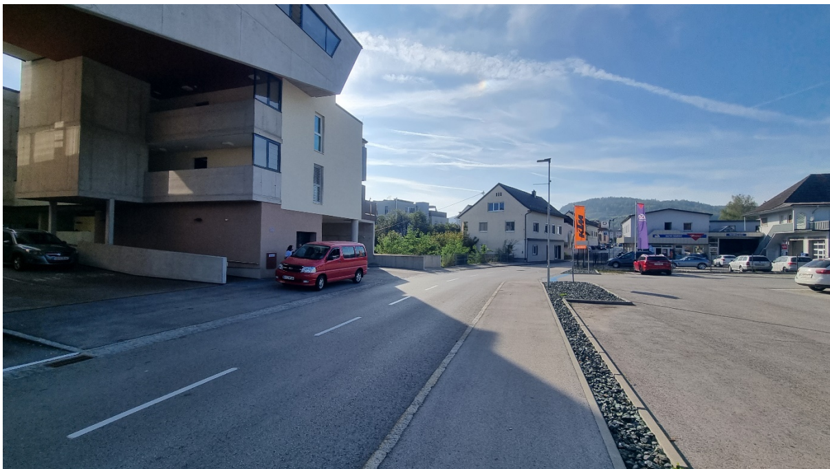
Blick Richtung Westen mit dem Projekt „Postplatzl“ und der Klagenfurter Straße mit dem westlichen Nachbargebäude und seinen Fenstern.
